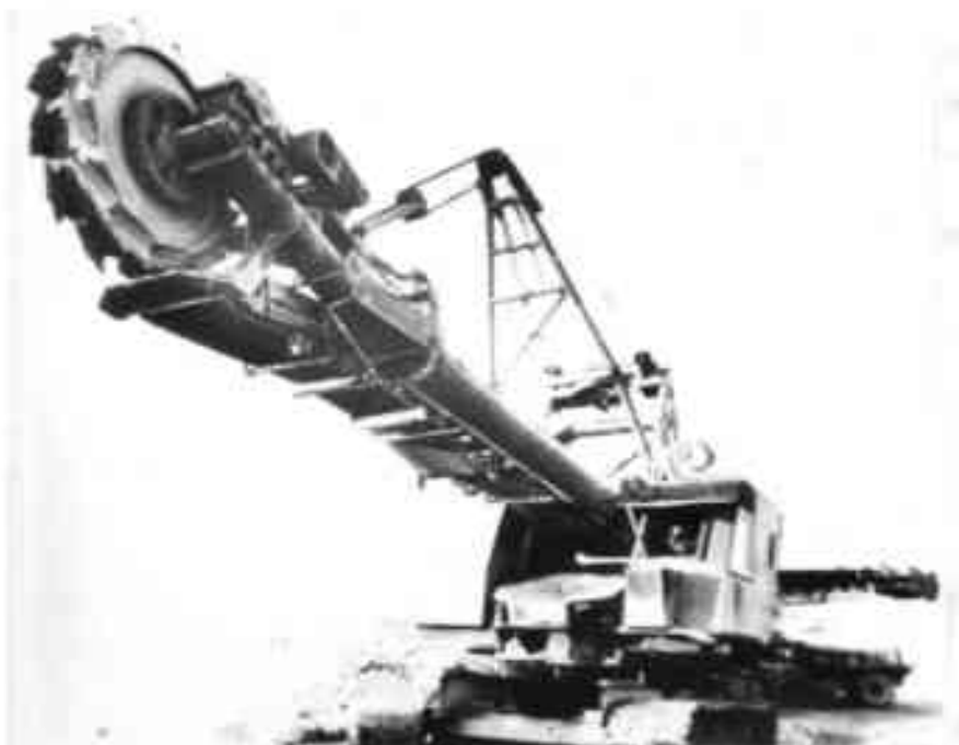
Рисунок 7 – Общий вид роторного экскаватора малой модели ЭР-200ИК производительностью 200 м 3 /ч и массой 40 т с бесковшовым ротором нижней разгрузки косоугольного резания
